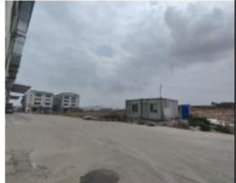
南面为园区污水处理站及空地
