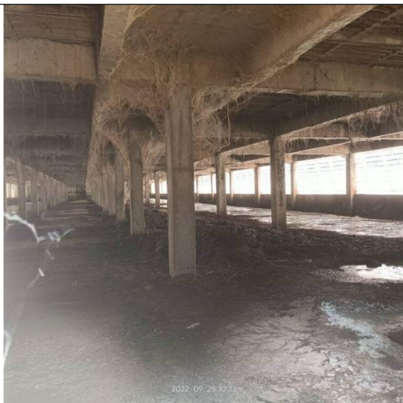
项目高架网床堆肥区
