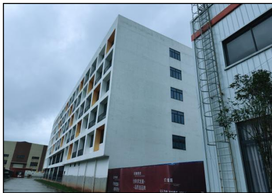
项目食堂及宿舍楼（空置）
