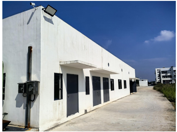
项目污水处理站
