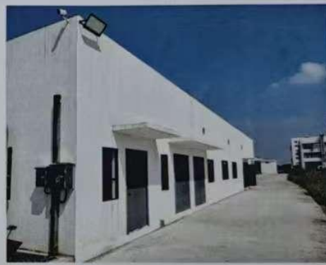
项目污水处理站
