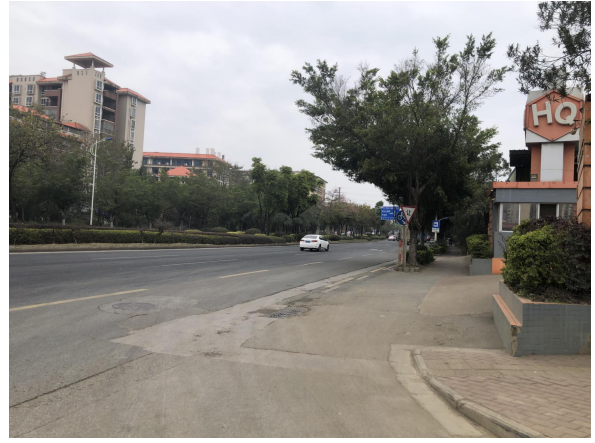
项目西面视图（柳石路）
