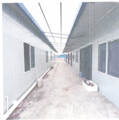
项目已建生活区
