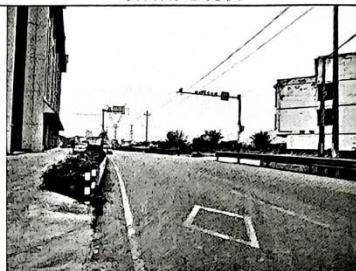
项目南面现状（067县道）
