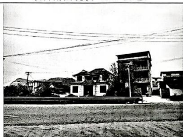
项目南面现状（南面土灵屯）
