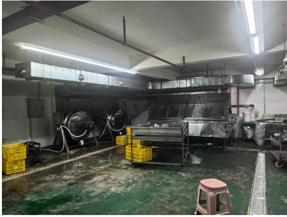
项目生产车间内部现状
