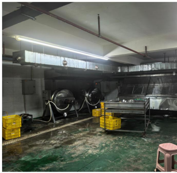
车间内部现状
