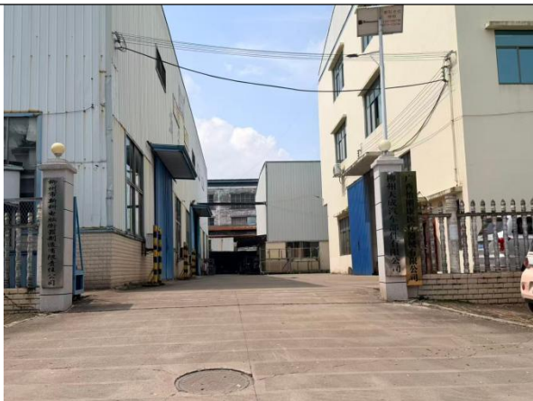
项目西面柳州天成汽车部件有限公司
